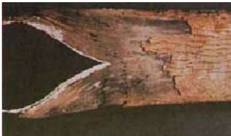
Rotura por oxidación térmica
