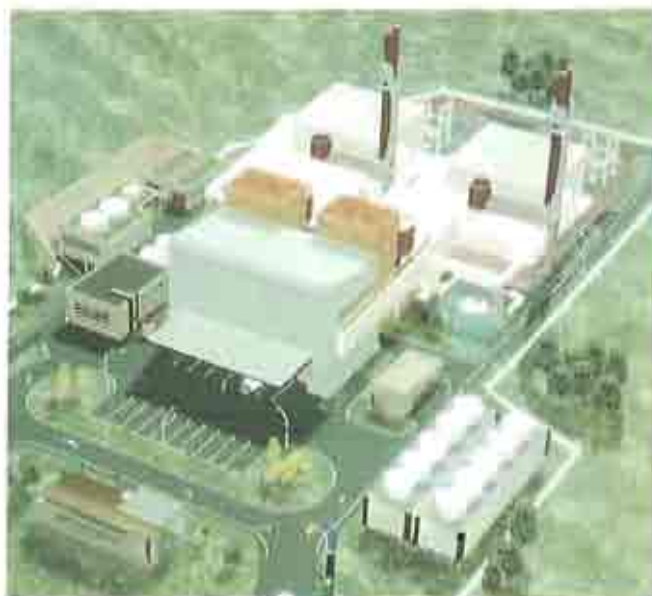
Fig. 5.11 Biomasa. Planta Integral de tratamiento de RSU mediante sistemas de clasificación, reciclaje e incineración con aprovechamiento energético
