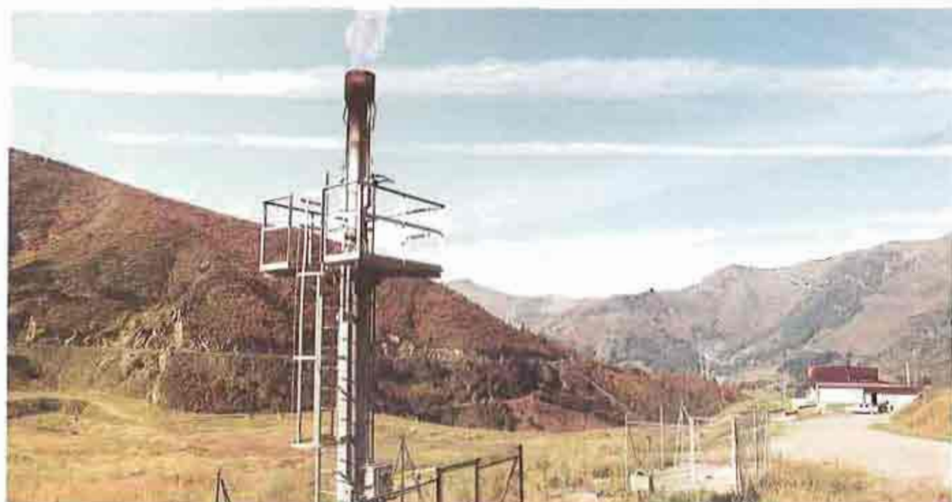
Fig. 5.13 Biomasa - Biogás Vertedero El aprovechamiento energético del biogás generado en vertedero derivado de los residuos sólidos urbanos será destinado a la producción eléctrica con un objetivo de alcanzar los 6.800 kW de potencia instalada en el año 2005
