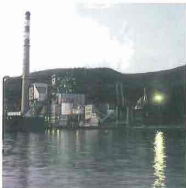
Fig. 2.20 Energía Eléctrica Central Térmica de Pasajes (Gipuzkoa)
