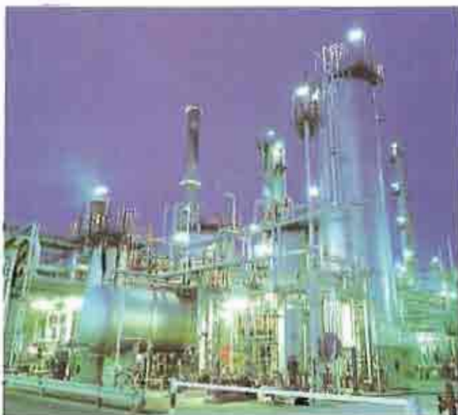
Fig. 2.23 Refino Instalaciones de la Refinería de PETRONOR en Muskiz (Bizkaia)
