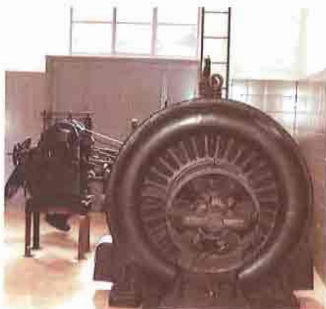
Fig. 5.9 Minihidráulica La rehabilitación de instalaciones minihidráulicas abandonadas seguirá siendo un objetivo de actuación continua
