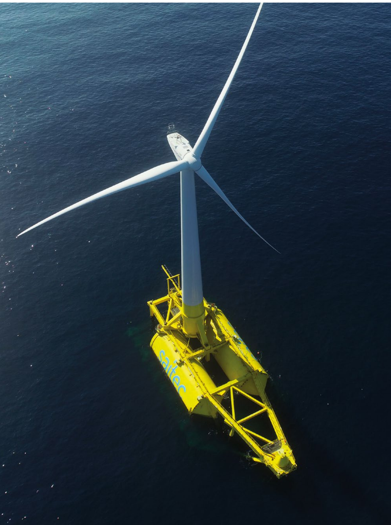
DISPOSITIVO INSTALADO EN BiMEP
