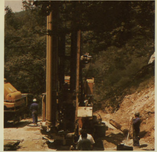
Sondeo de percusión para captación de aguas
