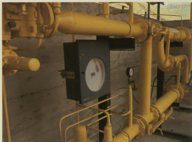
Estación de regulación y medida del usuario.
