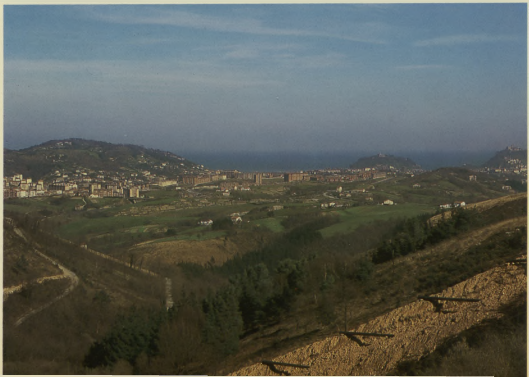
Construcción del gasoducto en las cercanías de S. Sebastián.
