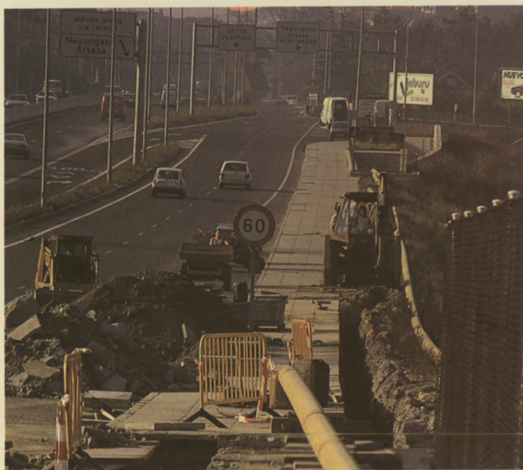
Construcción de red de distribución de gas natural y telecomunicaciones en Leioa.
