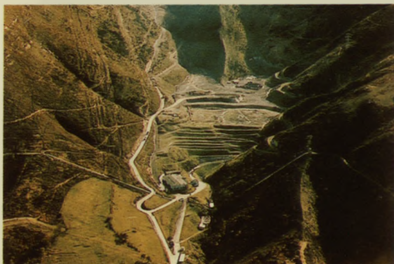
BioArtigas, S.A. Toma aérea.
