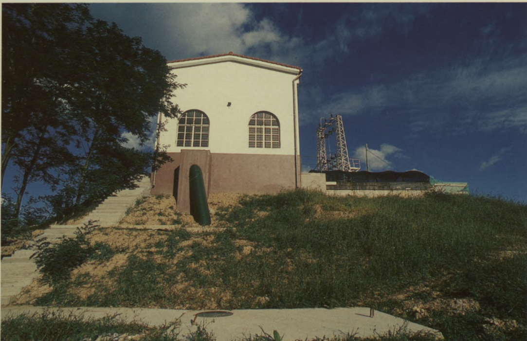
Aprovechamiento hidroeléctrico del embalse de Elordi, en Irún.
