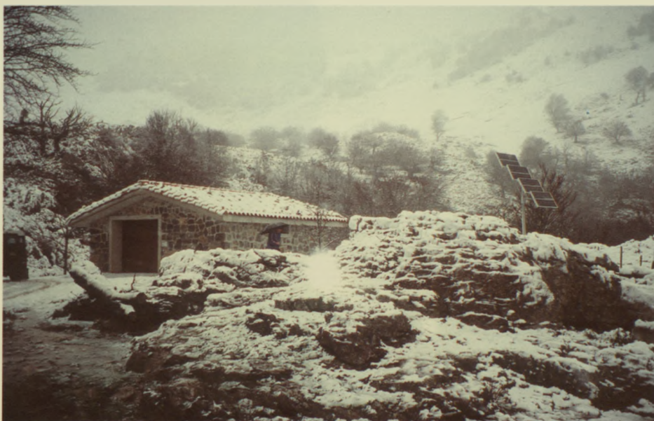
Instalación fotovoltaica para suministro eléctrico a una borda de pastoreo.
