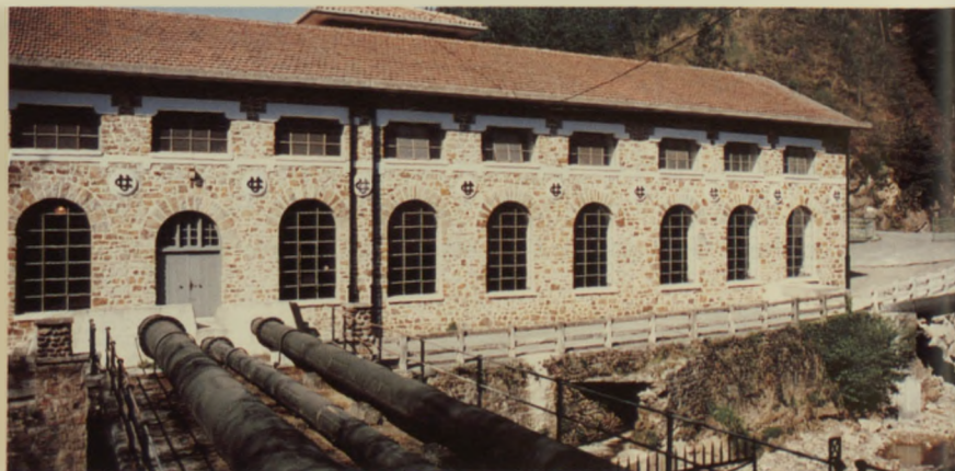
Entrada de tuberías forzadas en el edificio de la C. H. de Olate.
